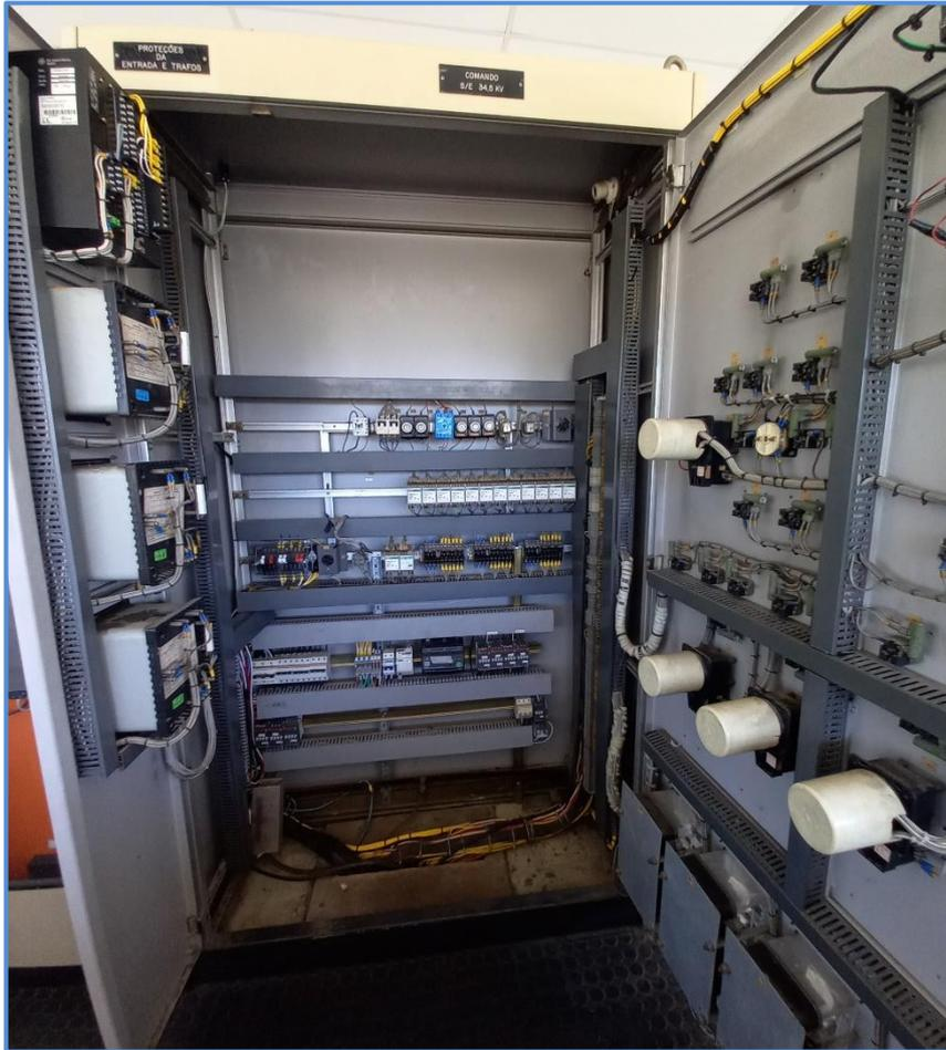
Figura 17. PCS – painel de controle da subestação.
