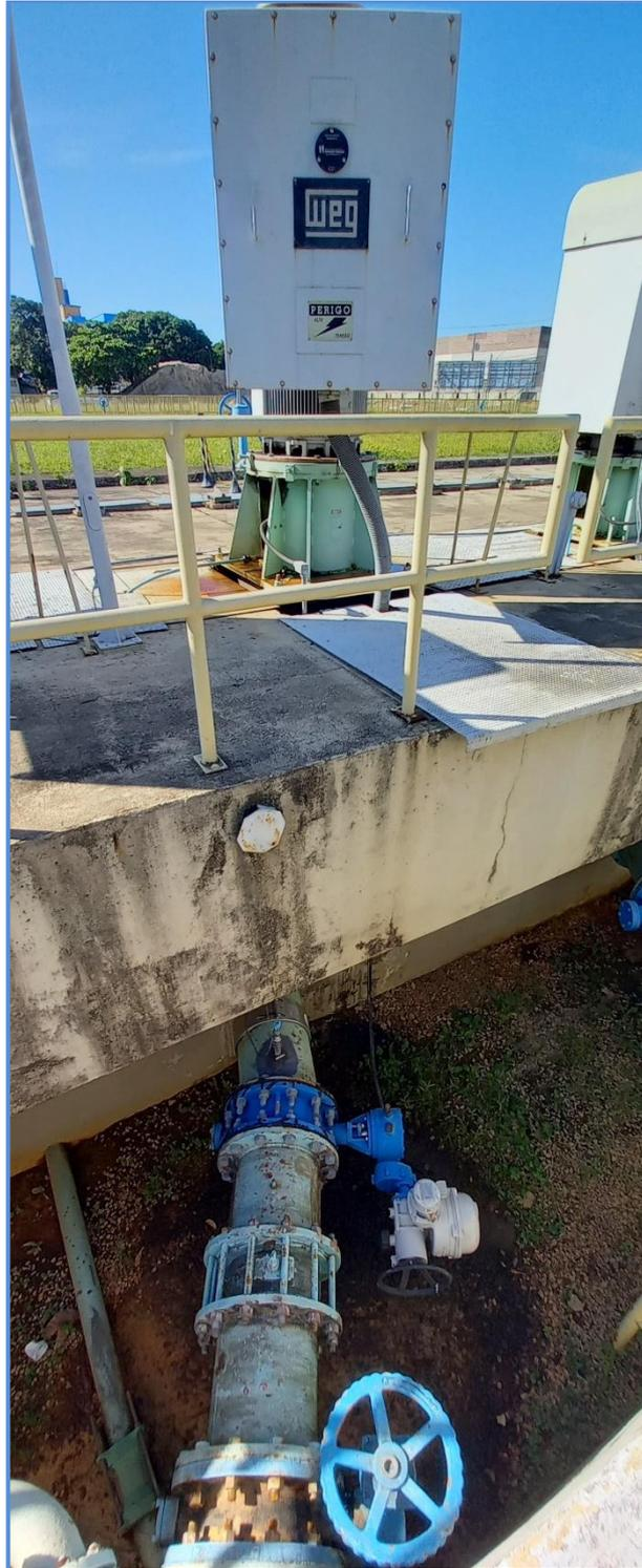
Figura 20. Conjunto motobomba e barriletes de recalque de água tratada.
