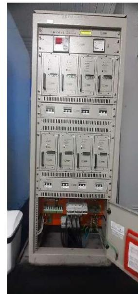
Figura14: Retificador Alto Recalque
