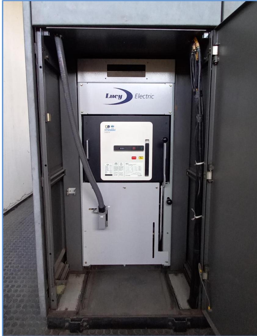
Figura 8. Cubículos MT 2,4KV, disjuntor inserido.
