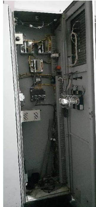
Figura 4: Cubículo comando Subestação
