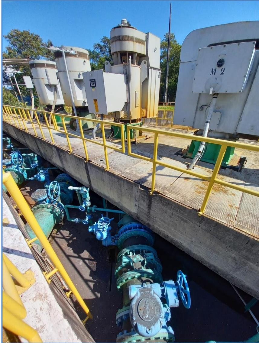
Figura 16. Barriletes de recalque de água bruta.
