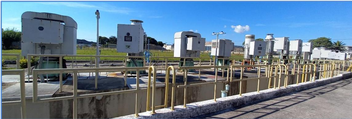
Figura 19. Conjuntos motobomba recalque de água tratada.
