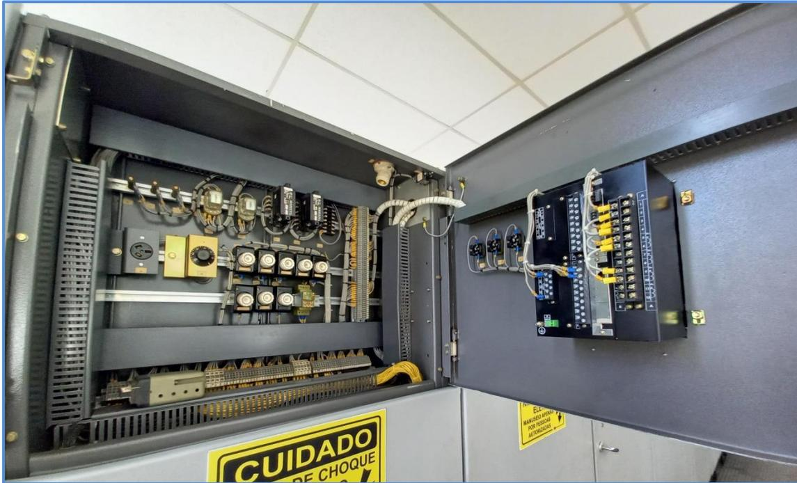
Figura 9. Cubículo MT 4,16KV, painel de comando.
