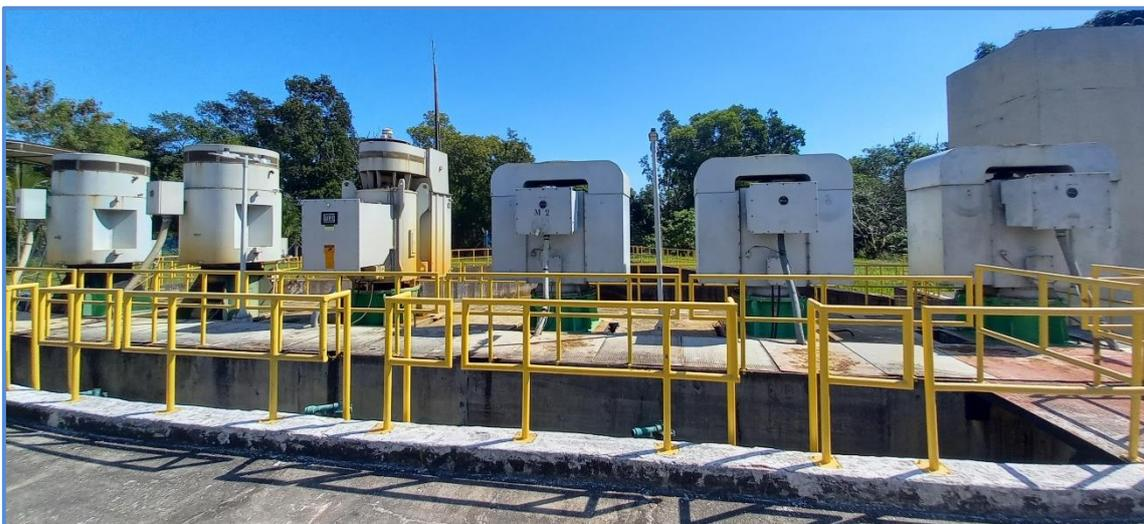
Figura 15. Conjuntos motobomba recalque de água bruta.
