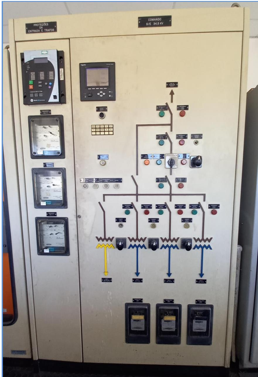
Figura 16. PCS – painel de controle da subestação.
