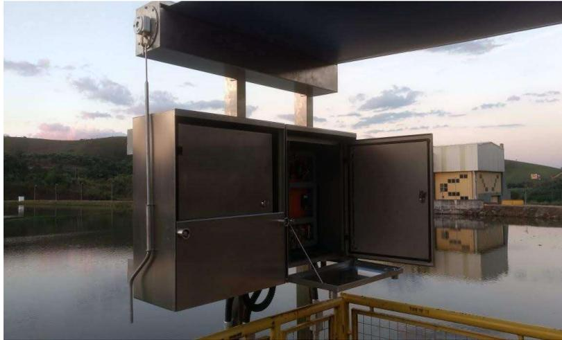
*Figura 7: Exemplo de painel com a proteção térmica externa.*
