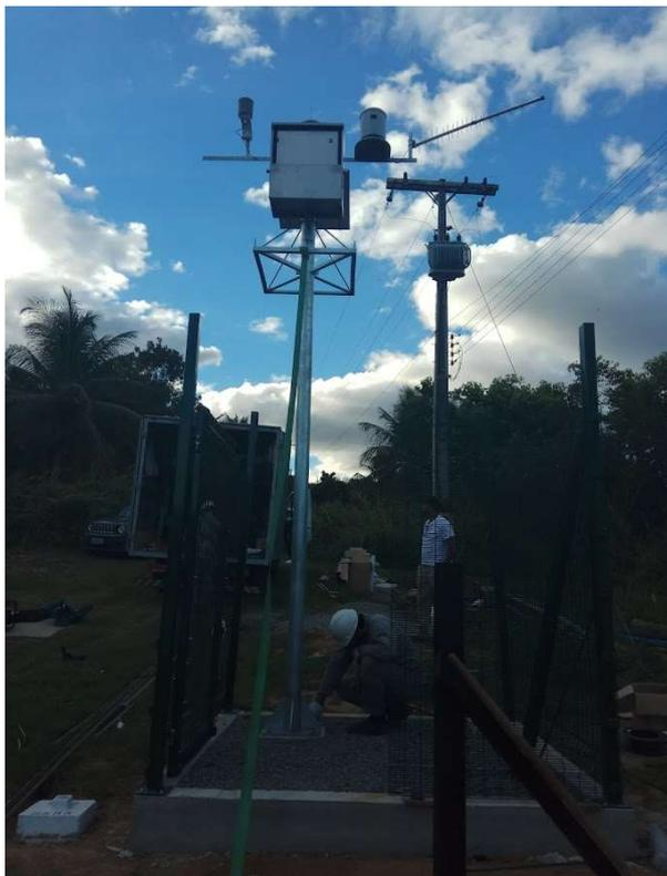
Figura 11: Exemplo de UTR em poste com os suportes para apoio de escadas
