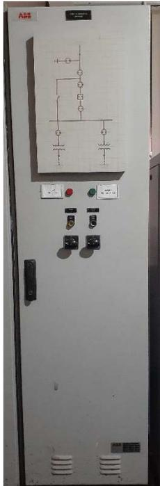
Figura 3: Cubículo comando Subestação
