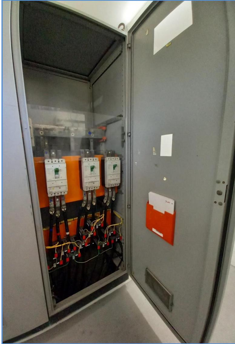
Figura 20. Painel de força 440V.
