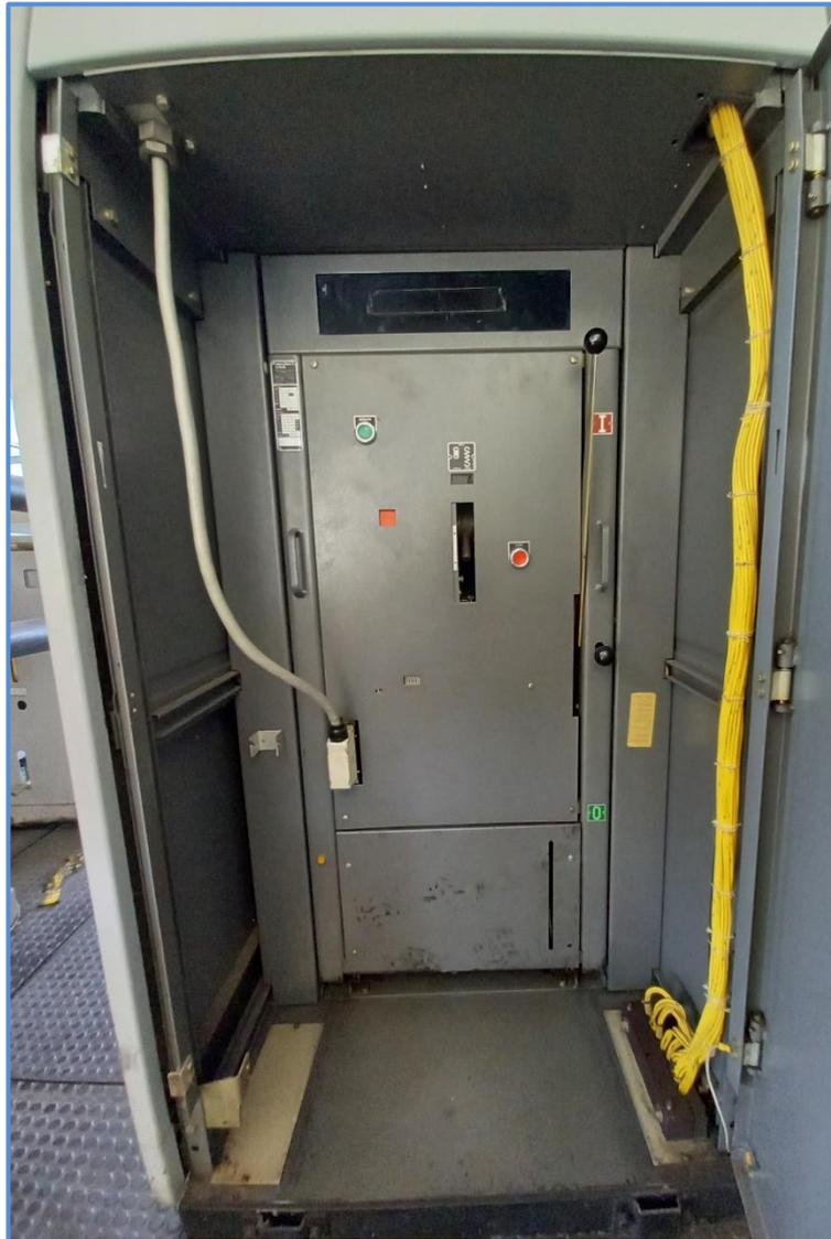
Figura 8. Cubículos MT 4,16KV, disjuntor inserido.
