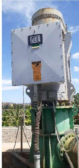
Figura 15: Conjunto moto - bomba Alto Recalque
