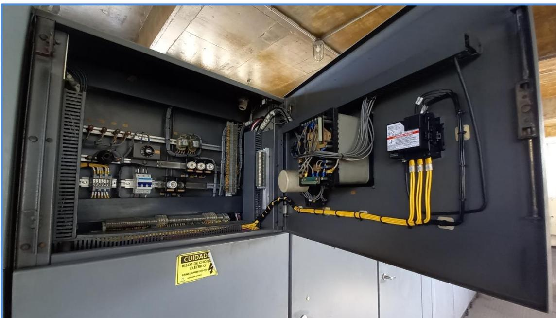
Figura 9. Cubículo MT 2,4KV, painel de comando.
