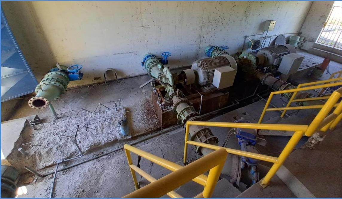
Figura 21. Conjuntos motobomba, recalque de água tratada.
