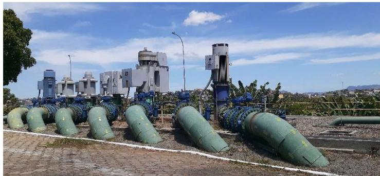
Figura 16: Conjunto moto - bomba Alto Recalque
