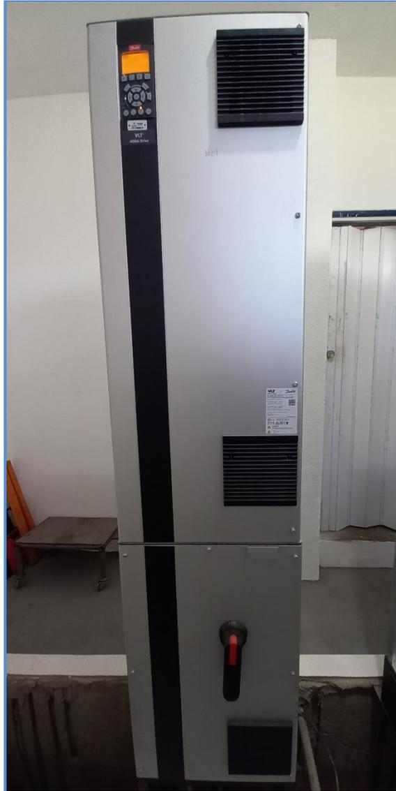
Figura 18. Inversor de acionamento motobombas.
