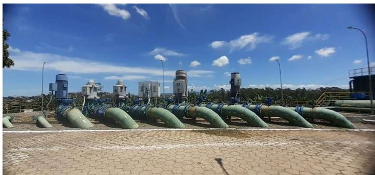
Figura 17: Conjunto moto - bomba Alto Recalque
