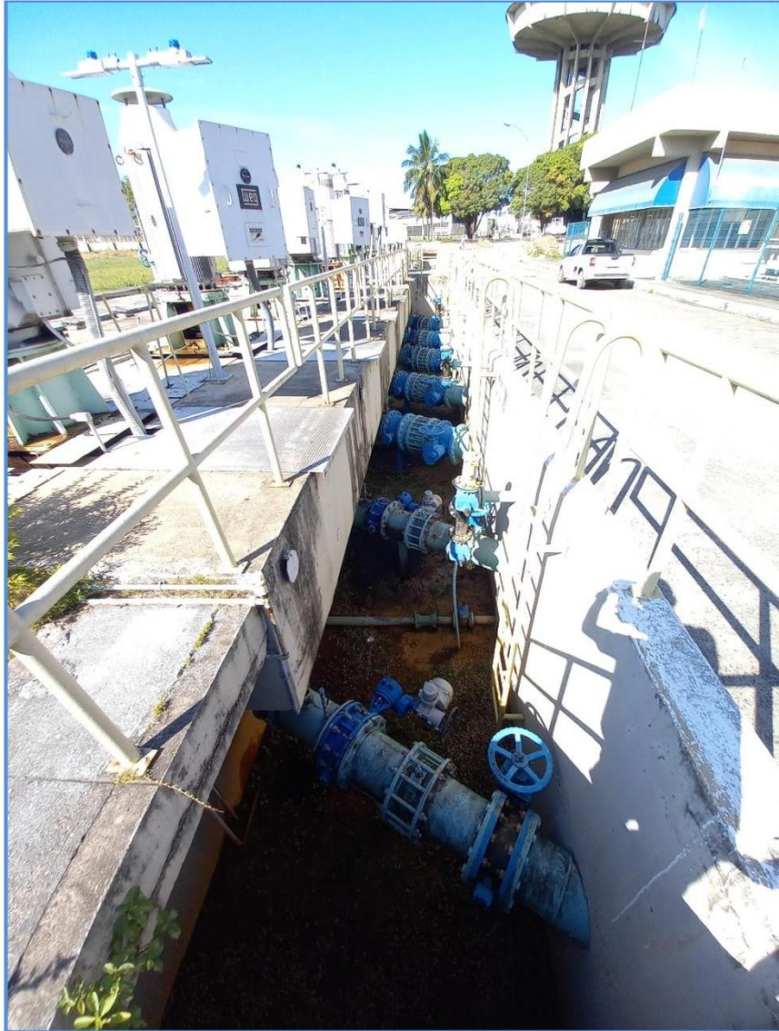
Figura 20. Barriletes de recalque de água tratada.
