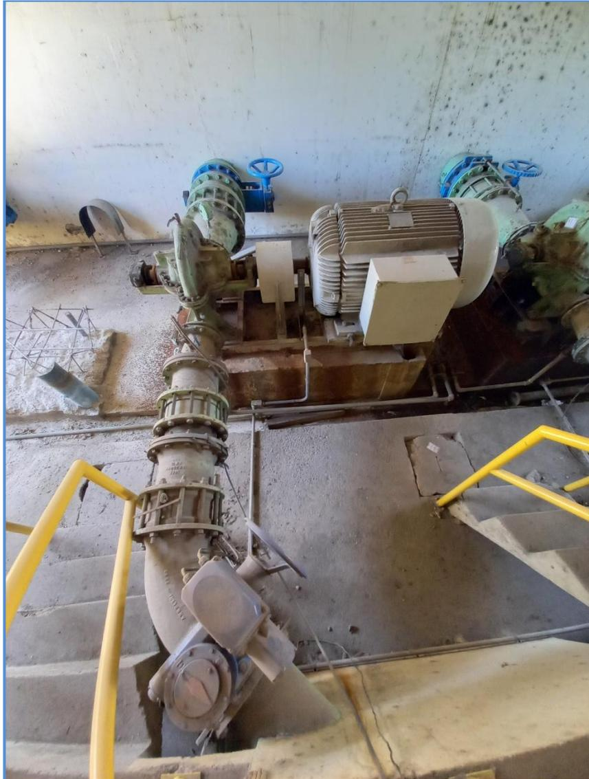
Figura 22. Conjunto motobomba e barrilete, recalque de água tratada.
