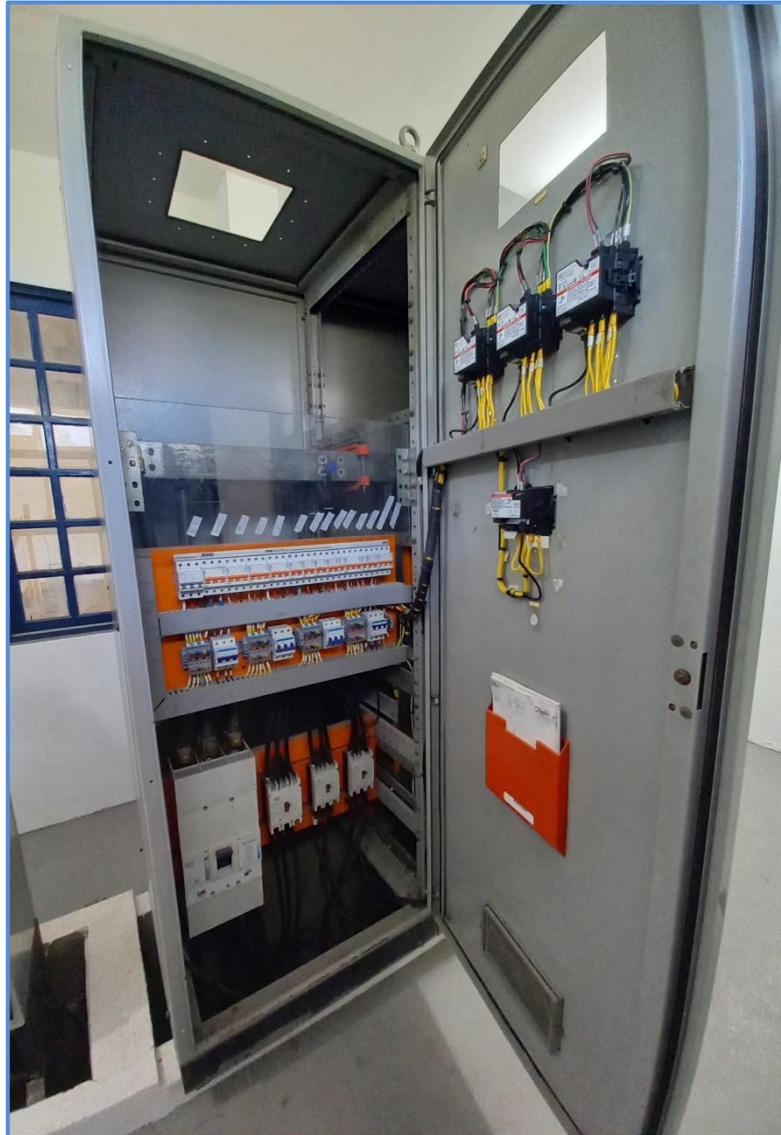
Figura 19. Painel de força 440V.
